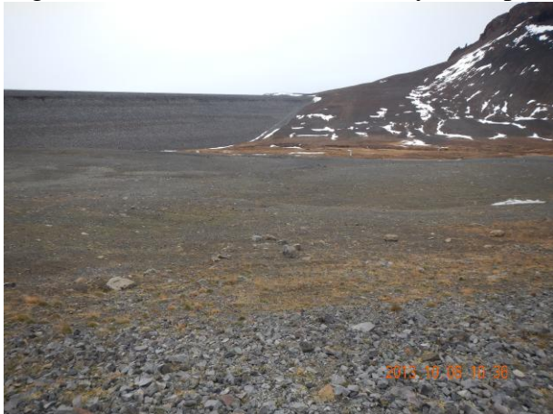
Mynd 19. Yfirlitsmynd nærri stíflu. N64°56.257 W15°45.838. RIH.
